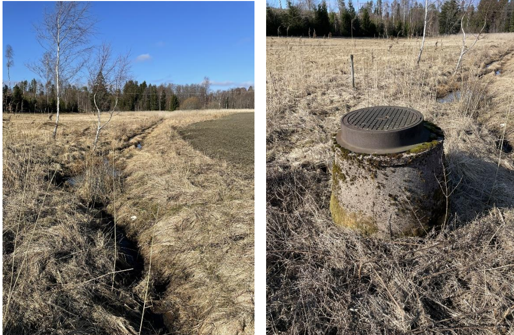
Figur 7. Dike och dagvattenledningsbrunn som leder dagvatten till Trobbofjärden.
